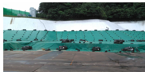
キャッピングシート使用事例 (特定廃棄物埋立処分施設)
