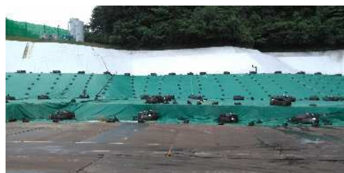
キャッピングシート使用事例 (特定廃棄物埋立処分施設)
