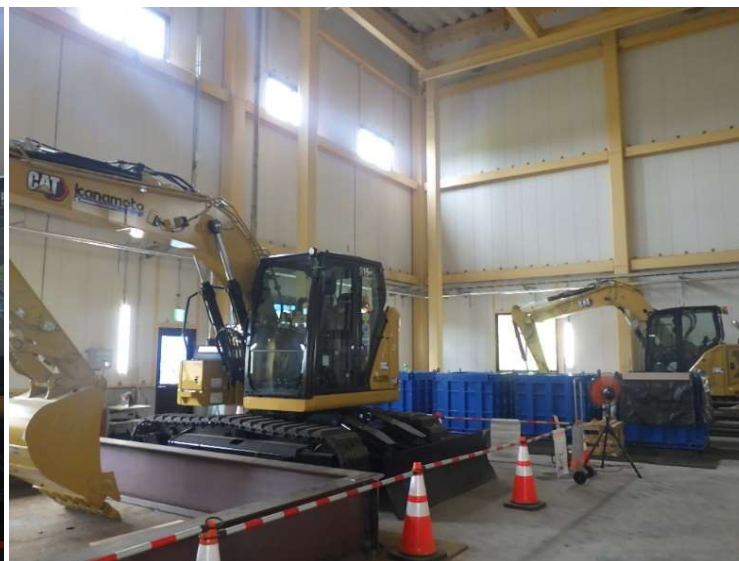
不燃物詰替設備②
