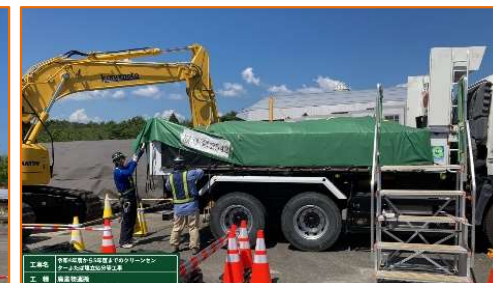
不燃物の積み込み及びシート掛けの様子
