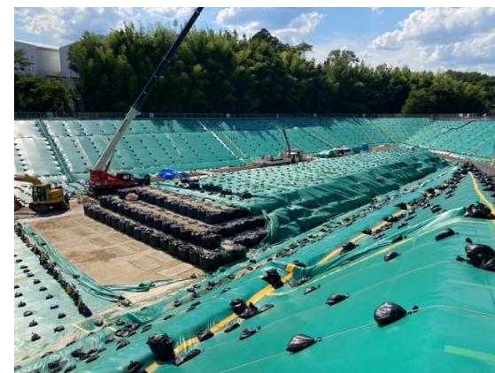
2期埋立区画埋立作業の様子 (令和5年9月撮影)
