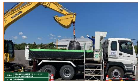
不燃物の積み込み及びシート掛けの様子
