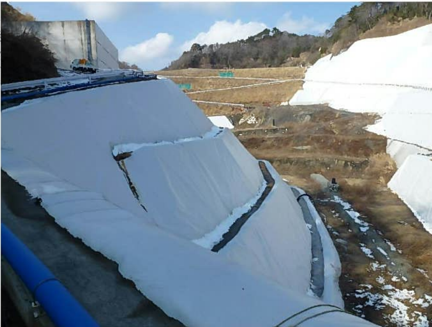
図2 2015年2月13日の現場状況（右岸側より埋立地を撮影）
