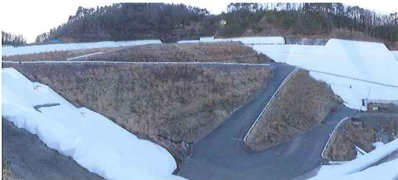
図2 2016年2月19日の現場測定時状況（中継端子付近の天端部より埋立地を撮影）
