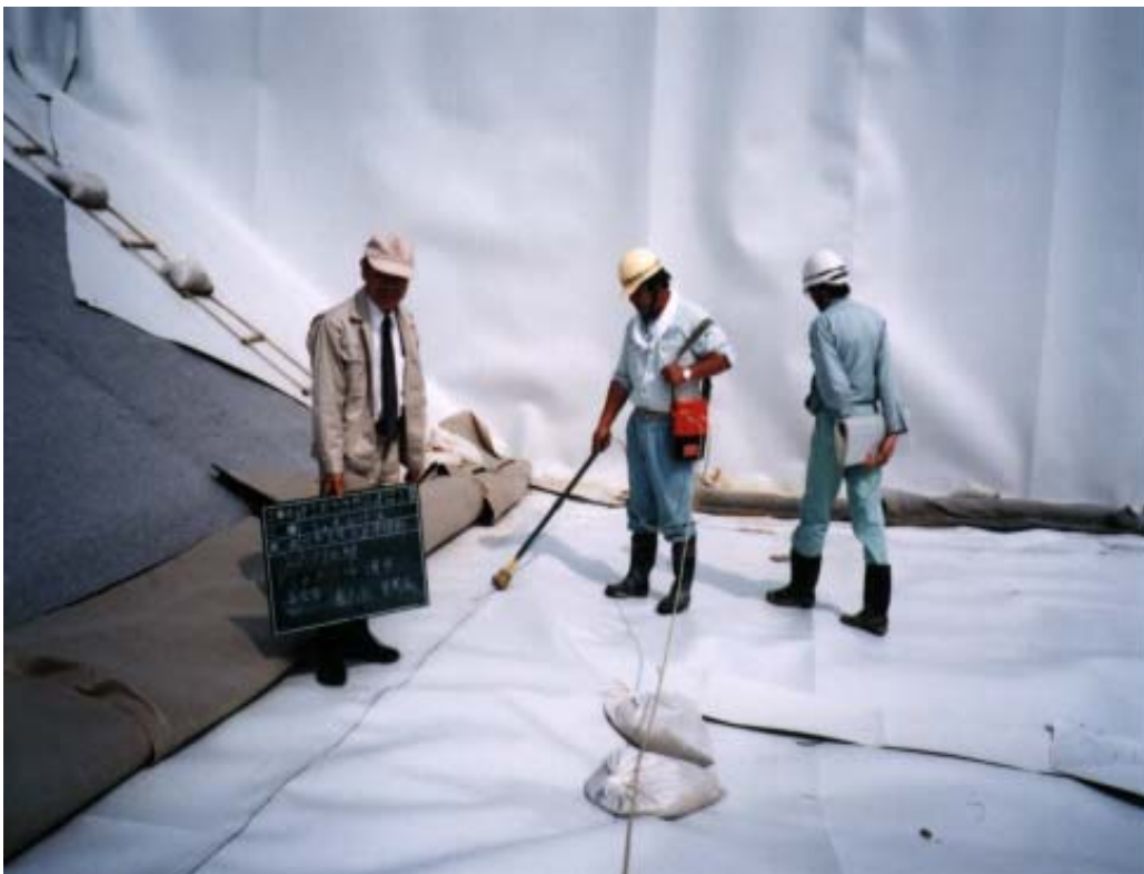
図2 スパーク検査状況
