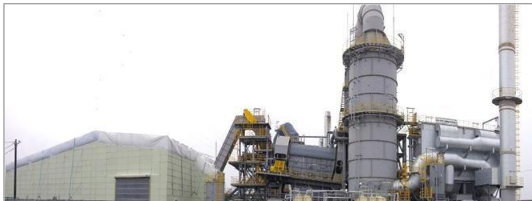
仮設焼却施設の例（相馬市）
