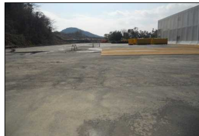
保管場①（事業完了後：南西側）
