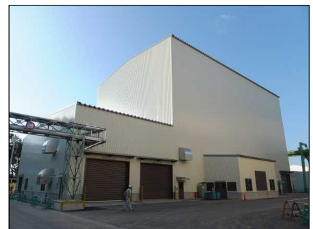
写真：福島県県中浄化センターに設置した仮設焼却施設
