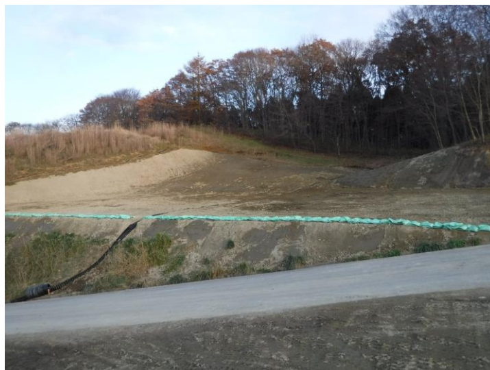
焼却施設解体後：平成 28 年 11 月
