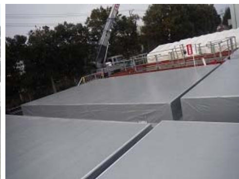
コンクリート板にシート敷設
