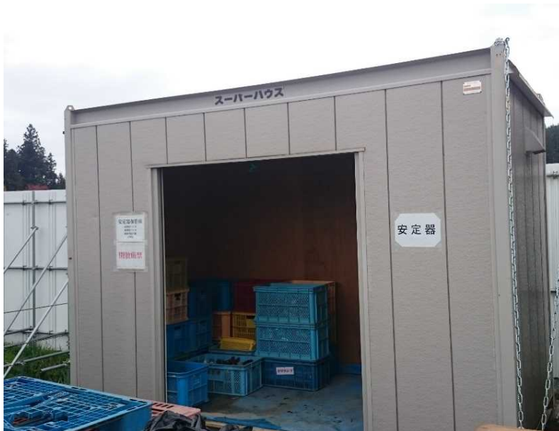
仮置場内のプレハブ倉庫
