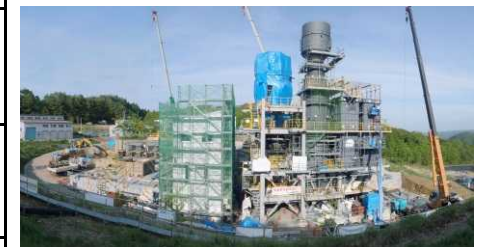
飯舘村小宮地区における仮設焼却炉の建設状況(平成26年5月)
