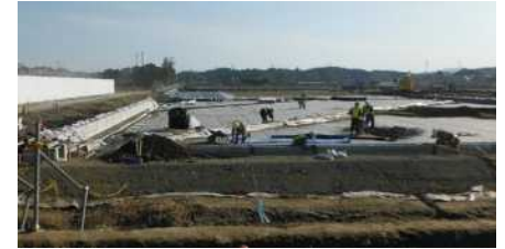
楢葉町前原地区における仮置場整備工事(平成26年4月)
