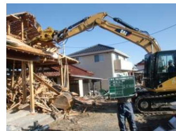
南相馬市岡田地区における被災家屋の 解体状況(平成26年2月)
