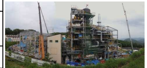
飯舘村小宮地区における仮設焼却炉の建設状況(平成26年6月)
