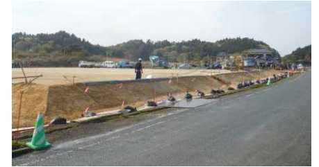
富岡町毛萱地区における仮置場整備工事(平成26年4月)
