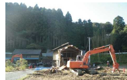
檜葉町における家屋解体の状況 (平成26年10月)
