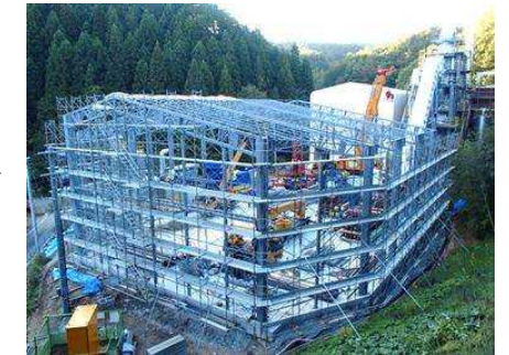
川内村における仮設焼却施設の建設状況(平成26年10月)
