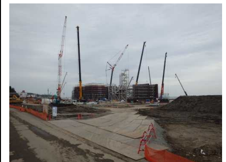
富岡町における仮設焼却施設の建設状況(平成26年10月)
