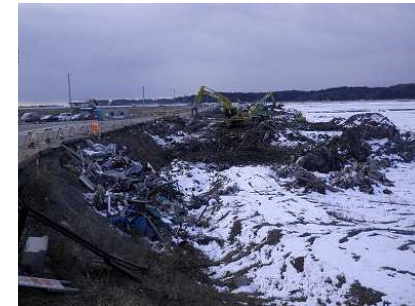
浪江町における 津波がれきの撤去状況 (平成27年2月)
