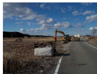
双葉町における 津波がれきの撤去状況 (平成27年2月)
