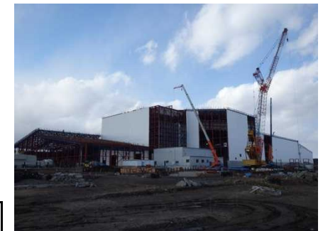
富岡町における仮設焼却施設の建設状況(平成27年2月)
