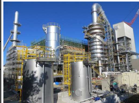
南相馬市における仮設焼却施設の建設状況(平成27年2月)
