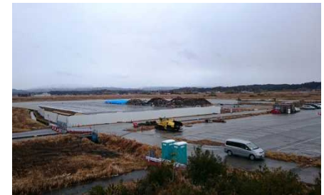
双葉町中野地区における仮置場の整備状況(平成27年2月)
