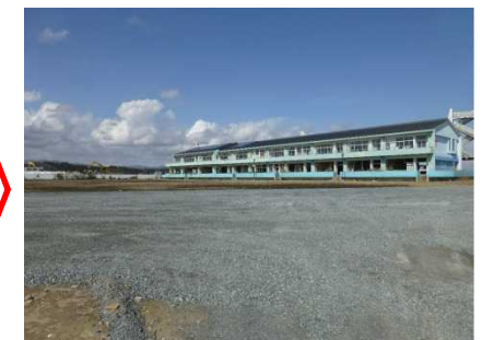
撤去後(平成27年3月)
