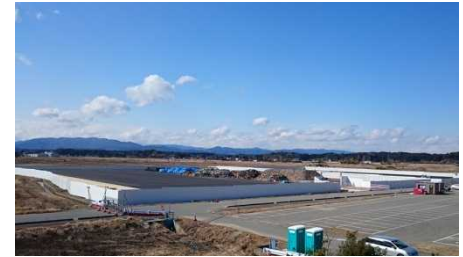
双葉町中野地区における仮置場の整備状況(平成27年3月)
