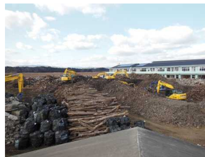
撤去前(平成26年1月)
