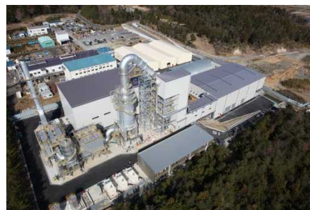
南相馬市の仮設焼却施設 (平成27年3月)
