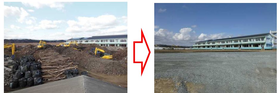
撤去前(平成26年1月)
