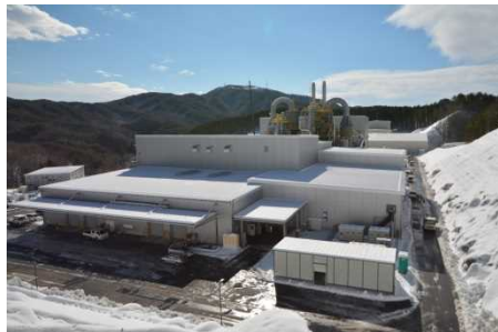
飯館村蕨平地区の仮設焼却施設 (平成28年1月)
