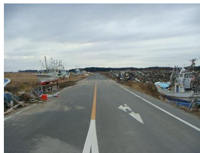
撤去前(平成26年7月)
