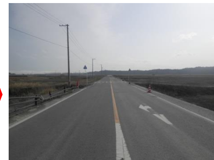
撤去後(平成28年3月)
