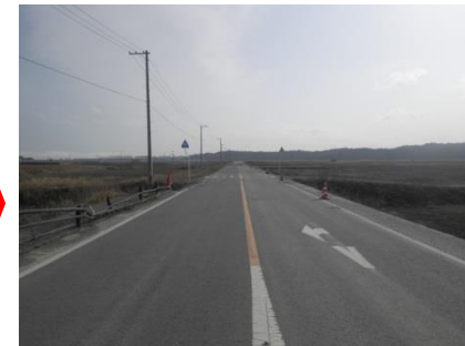
撤去後(平成28年3月)
