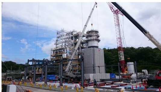
楢葉町の仮設焼却施設 (平成28年6月)
