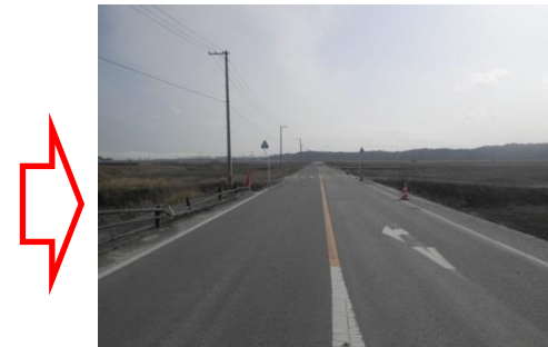
撤去後(平成28年3月)
