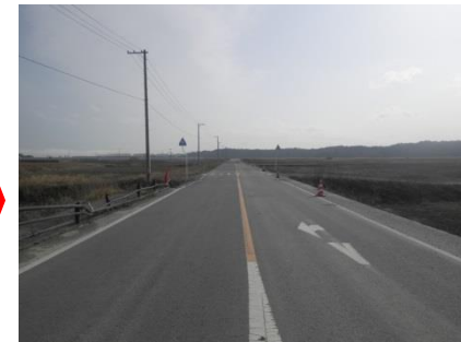
撤去後(平成28年3月)
