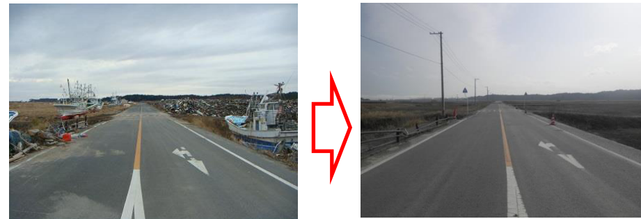
撤去前(平成26年7月)
