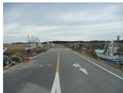
撤去前(平成26年7月)
