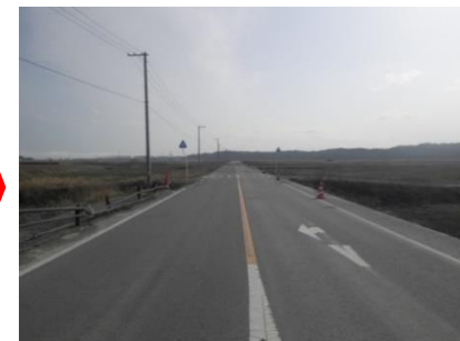
撤去後(平成28年3月)
