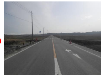
撤去後(平成28年3月)
