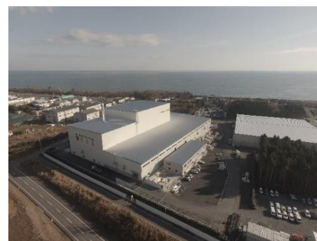
大熊町の仮設焼却施設
