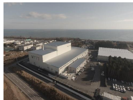
大熊町の仮設焼却施設
