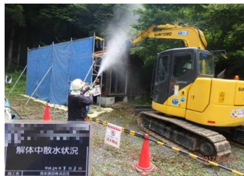
被災家屋等の解体の様子
