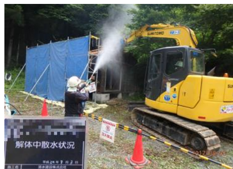
被災家屋等の解体の様子
