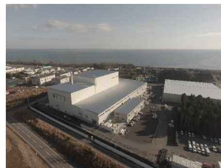
大熊町の仮設焼却施設
