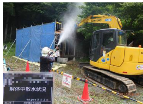
被災家屋等の解体の様子
