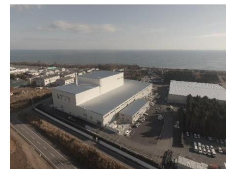
大熊町の仮設焼却施設
