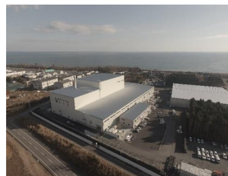
大熊町の仮設焼却施設
