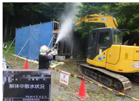
被災家屋等の解体の様子
