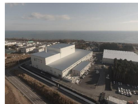
大熊町の仮設焼却施設
