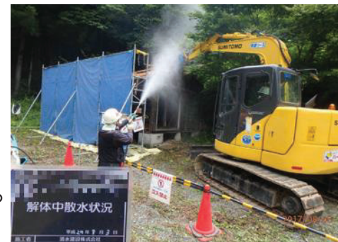
被災家屋等の解体の様子
