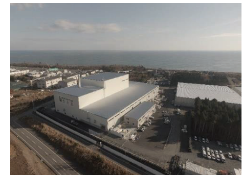
大熊町の仮設焼却施設
