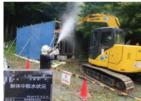
被災家屋等の解体の様子
