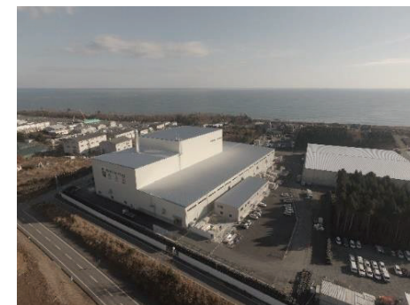
大熊町の仮設焼却施設
