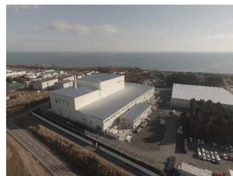
大熊町の仮設焼却施設
