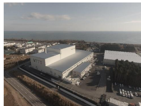
大熊町の仮設焼却施設
