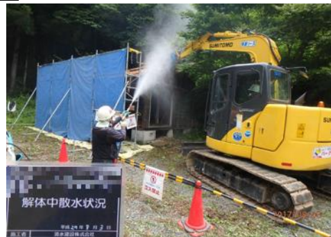
被災家屋等の解体の様子
