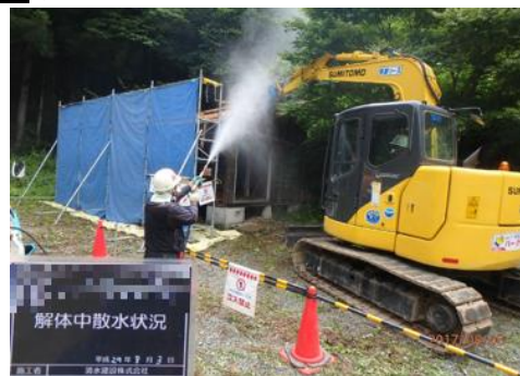
被災家屋等の解体の様子
