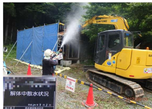
被災家屋等の解体の様子
