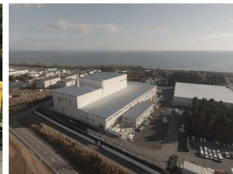
大熊町の仮設焼却施設
