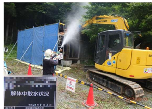
被災家屋等の解体の様子
