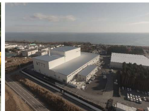
大熊町の仮設焼却施設
