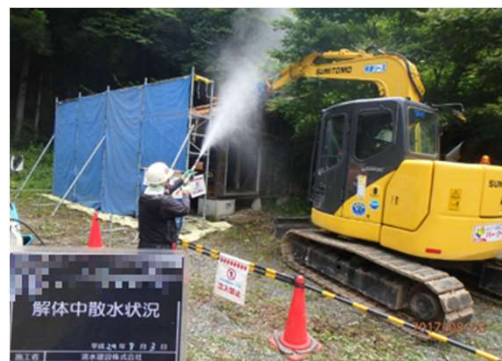
被災家屋等の解体の様子
