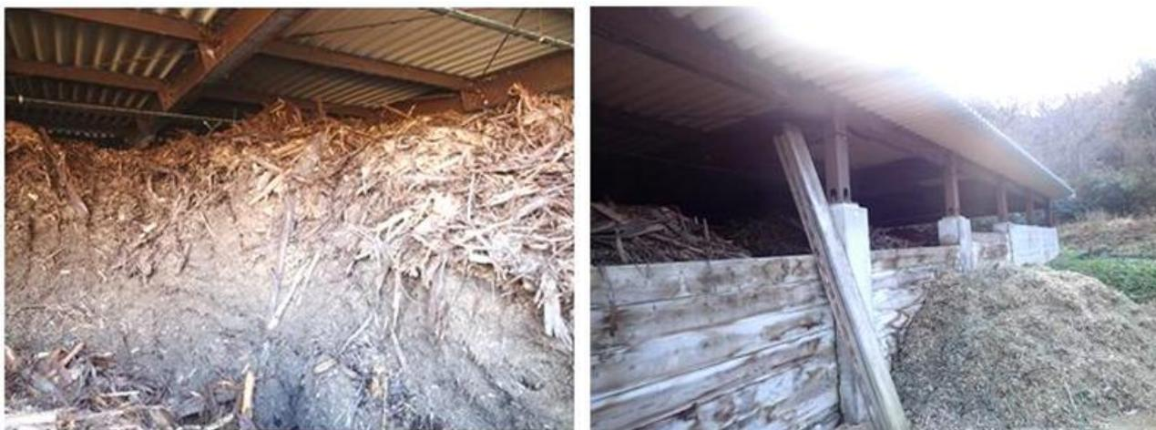
図 2- 6 脱臭設備（バーク）の事例
