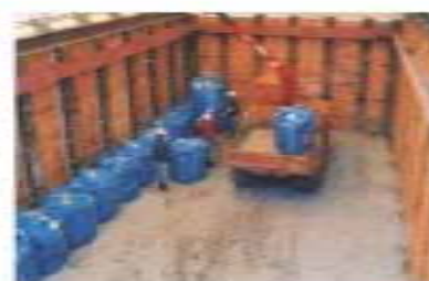
廃棄物定置作業
