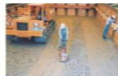
覆土施工状況
