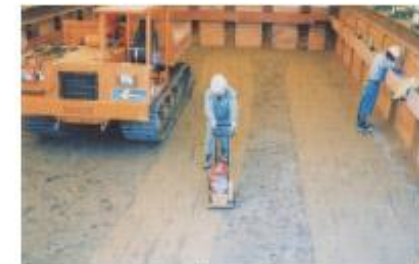
覆土施工状況
