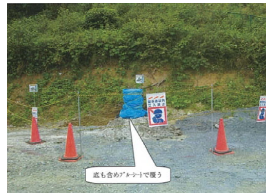
指定廃棄物の保管状況
