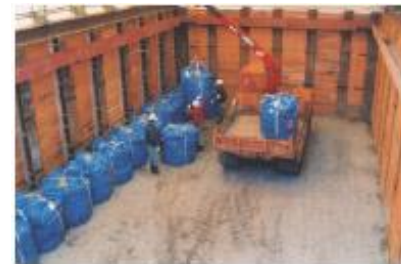
廃棄物定置作業
