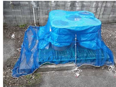
ワイヤーで基礎に固定
