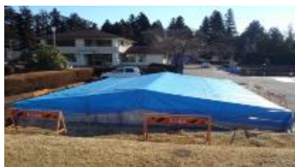
(天日乾燥床をブルーシートで被覆)
